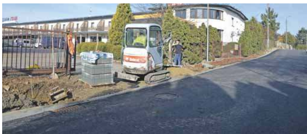
Trwa m.in. układanie chodników
