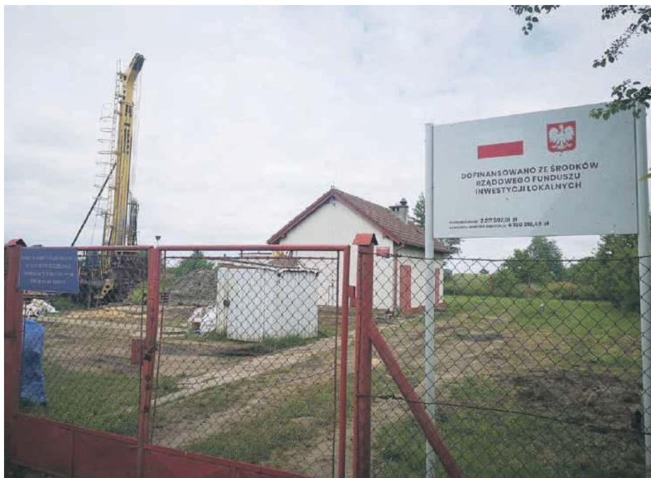
Inwestycja w Sobocisku jest w trakcie realizacji
