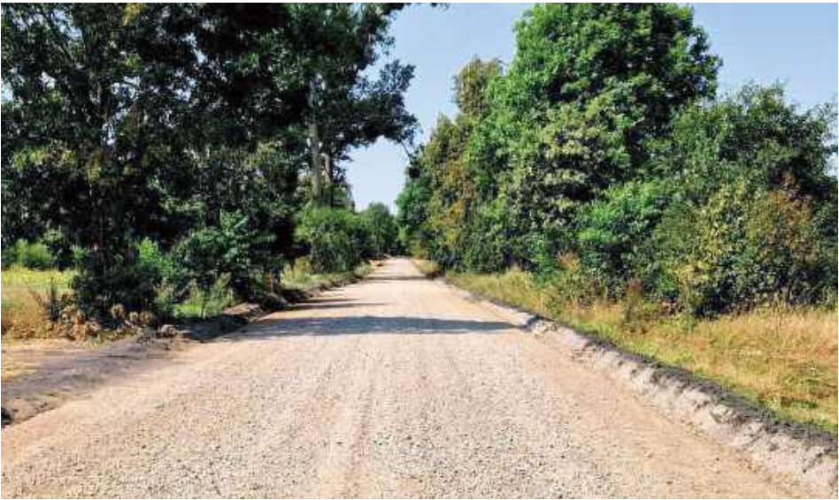
Prace trwają, niedawno wykonana została m.in. podbudowa drogi. Chodzi o prawie 2-kilometrowy trakt „Zamoszczany”, łączący trasę wojewódzką numer 815 z dawną DW 818, a dzisiaj drogą powiatową (do Włodawy i w kierunku jezior Pojezierza Łęczyńsko-Włodawskiego)
