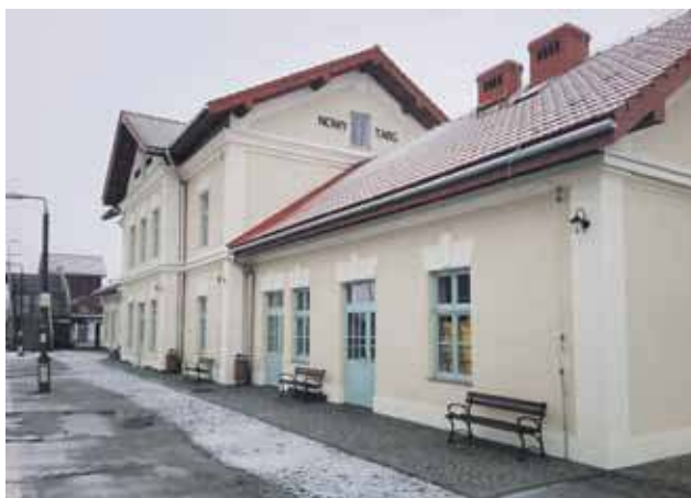
Nowotarski dworzec po remoncie możemy podziwiać, ale wciąż tylko z zewnątrz.
