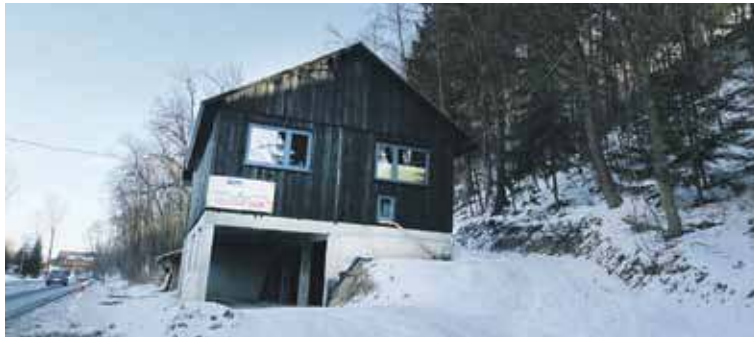
Remont szopy przy zakopiance: na drodze do pól rośnie "budynek garażowy", za zajęcie terenu przy drodze krajowej inwestor płaci codziennie karę w wysokości 23 zł.
