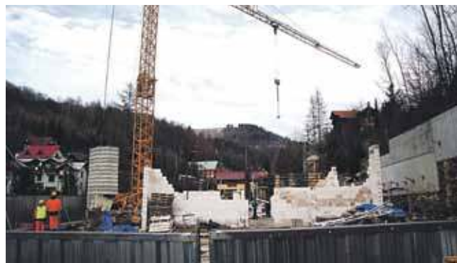
Ponownie ruszyły prace przy komisariacie policji w Szczawnicy.
