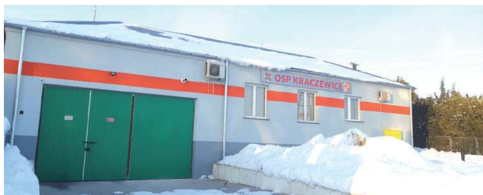
(ac) Tak prezentuje się remiza w Kraczevicach po zakończonej termomodernizacji
