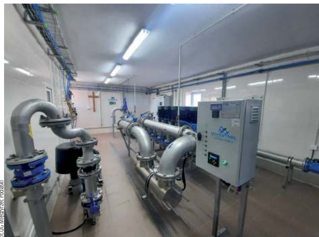
Przebudowano m.in. stację uzdatniania wody w Rogoźnicy
