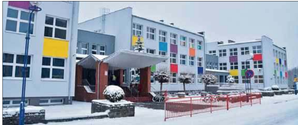
Tak prezentuje się budynek po termomodernizacji.
