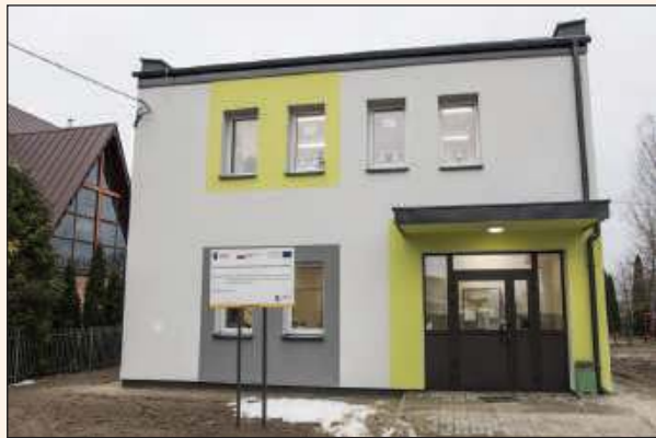
Przedszkole w Bazanowie po termomodernizacji
