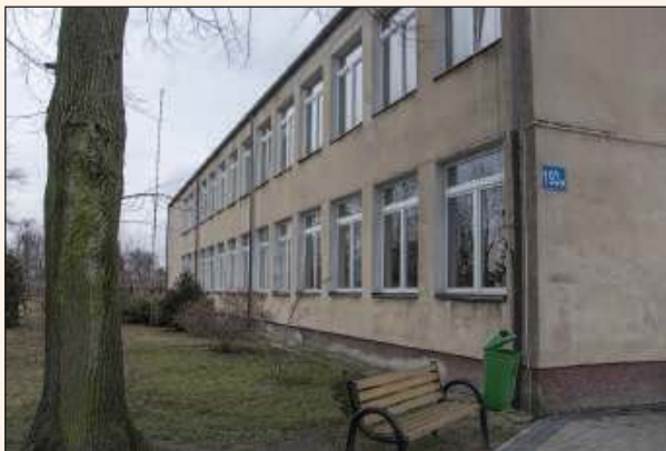
PSP w Swatach przed termomodernizacją
