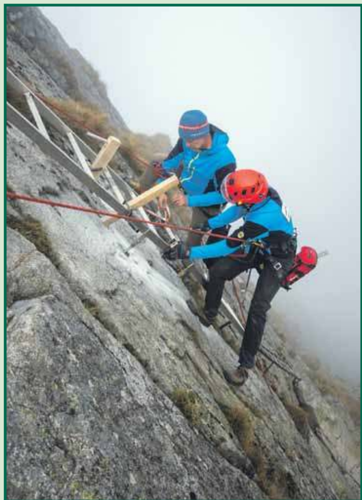
Montaż górnego odcinka nowej drabinki.
