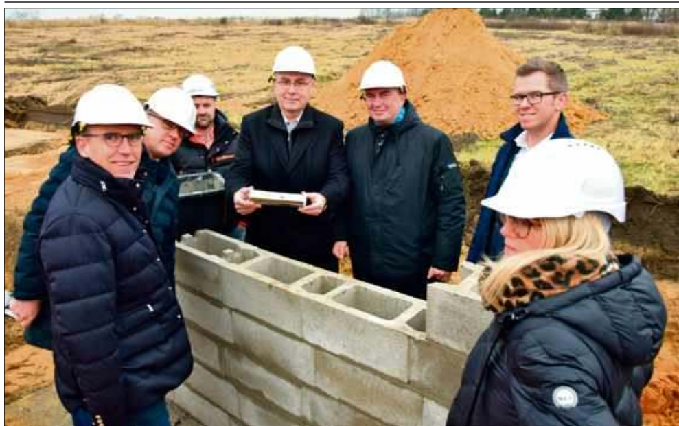
Budowa nowego zakładu już się rozpoczęła.
