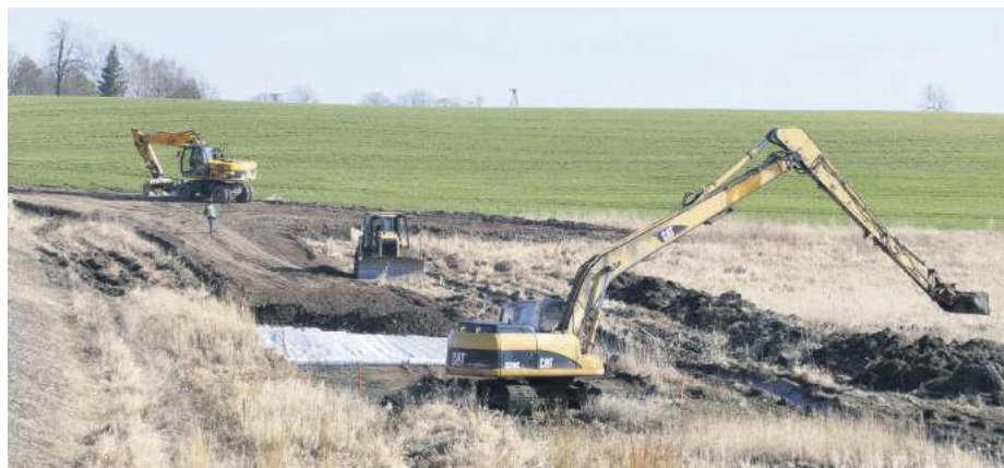
Ruszył remont zbiornika zalewowego w Przewornie. Uszczelnienie tamy i budowlu spustowej będzie kosztować około 4 mln zł
