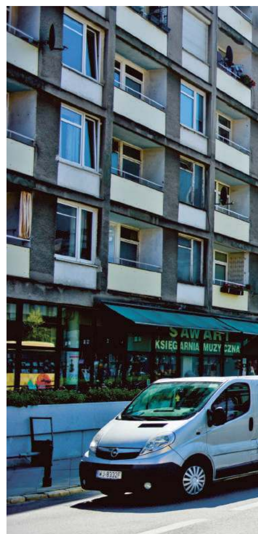
Na miejscu zabytku stoi dziś szpetny blok (po lewej) | fot. Marcin Pegaz/Gazeta Polska
