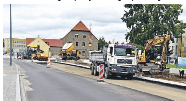
Ruch w obu kierunkach zostanie dopuszczony po wykonaniu oznakowania docelowego na rondzie - poziomego i pionowego
