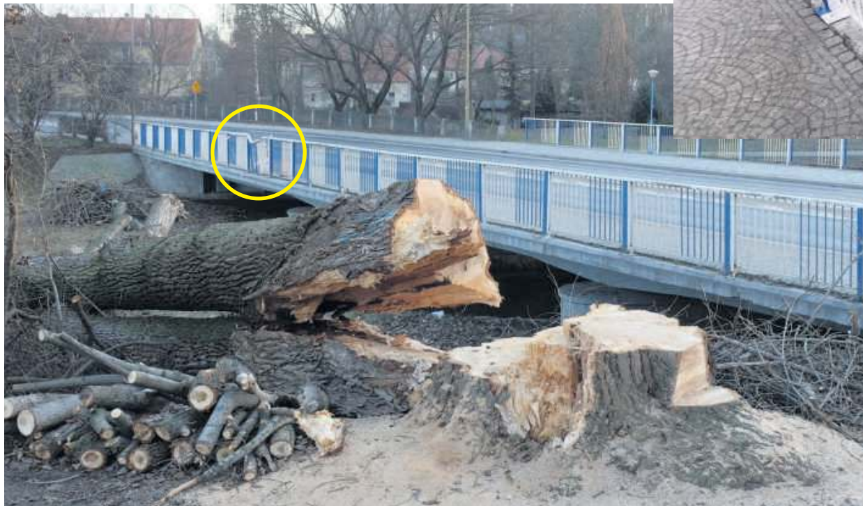
Ścięta topola, upadając zgięła fragment barierki mostu (zaznaczony żółtym kółkiem). Foto: P. Krzyżanowski
