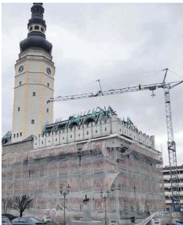
Bryła ratusza jest już prawie ukończona
