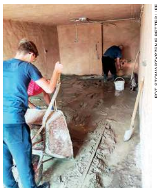
Wakacyjne prace remontowe w powstającym „Miętowym Zakątku”
