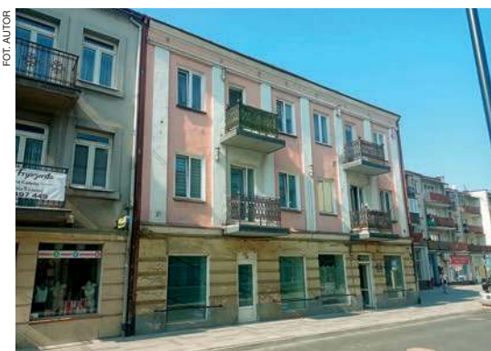
Budynki, na których powstaną zielone fasady
