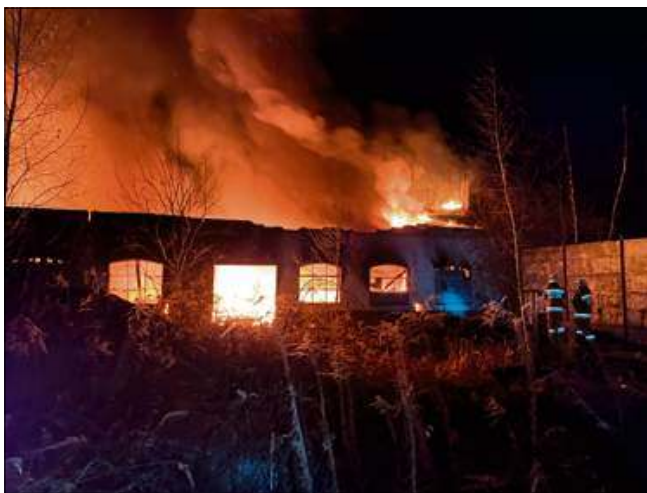
Ogień strawił stary zakład, w którym produkowano gumowe taśmociągi.
