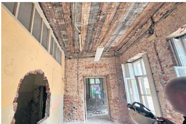
Wykonano między innymi niezbędne prace rozbiórkowe oraz kluczowe roboty przygotowawcze i zabezpieczające.
