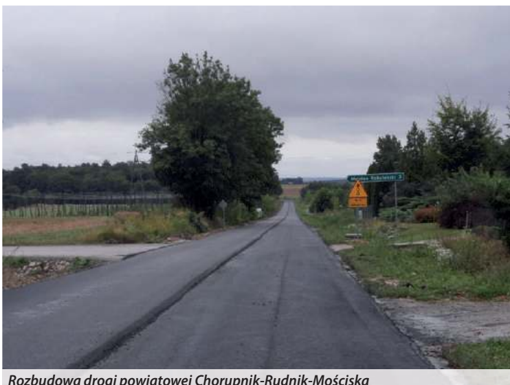
Rozbudowa drogi powiatowej Chorupnik-Rudnik-Mościska
