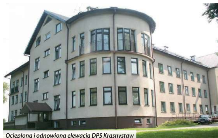
Ocieplona i odnowiona elewacja DPS Krasnostaw
