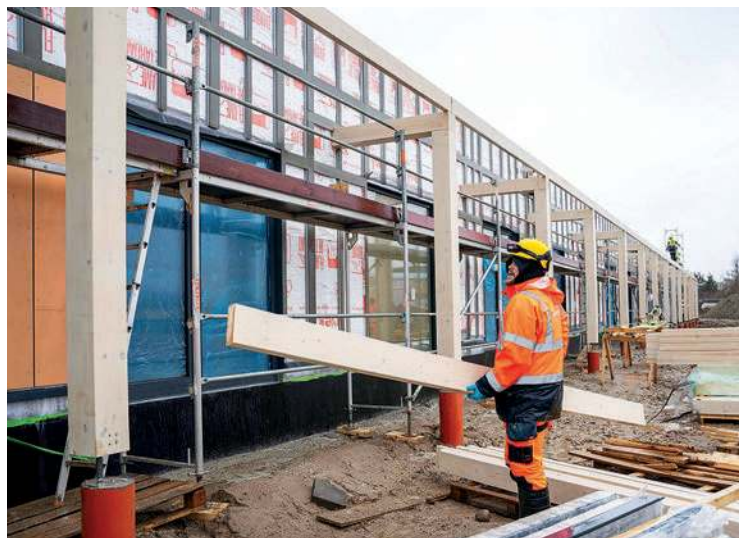
Budowa przy ul. Prymasa Tysiąclecia dobiega końca
