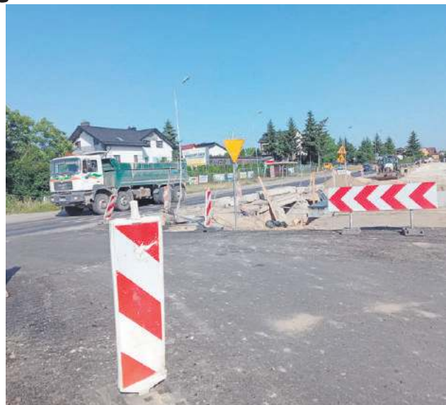
Od 29 czerwca można już przejechać ul. Okrzei na odcinku od ul. Dzieci Zamojszczyzny do mostu na rzece Łabuńce.
