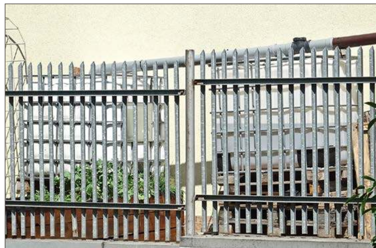
Na niektórych podwórkach deszczówka zbierana jest już od dawna.
