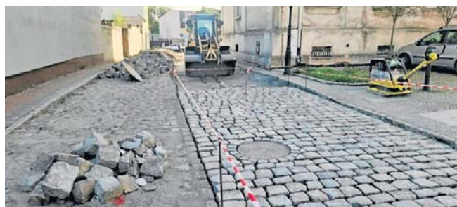
Trwa remont ulicy Księdza Tuszyńskiego w Grodzisku Wielkopolskim
