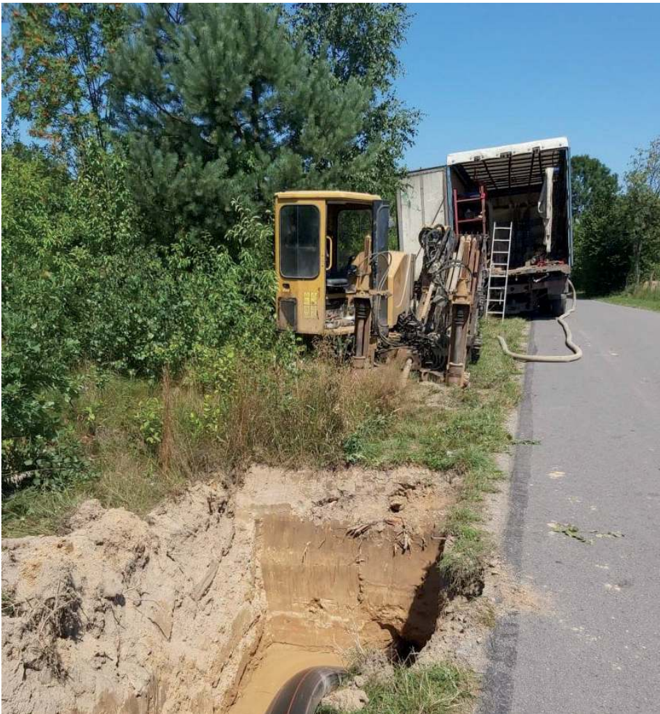
Trwa budowa ponad 6 km kanalizacji sanitarnej w miejscowości Sokołówka-Kolonia
