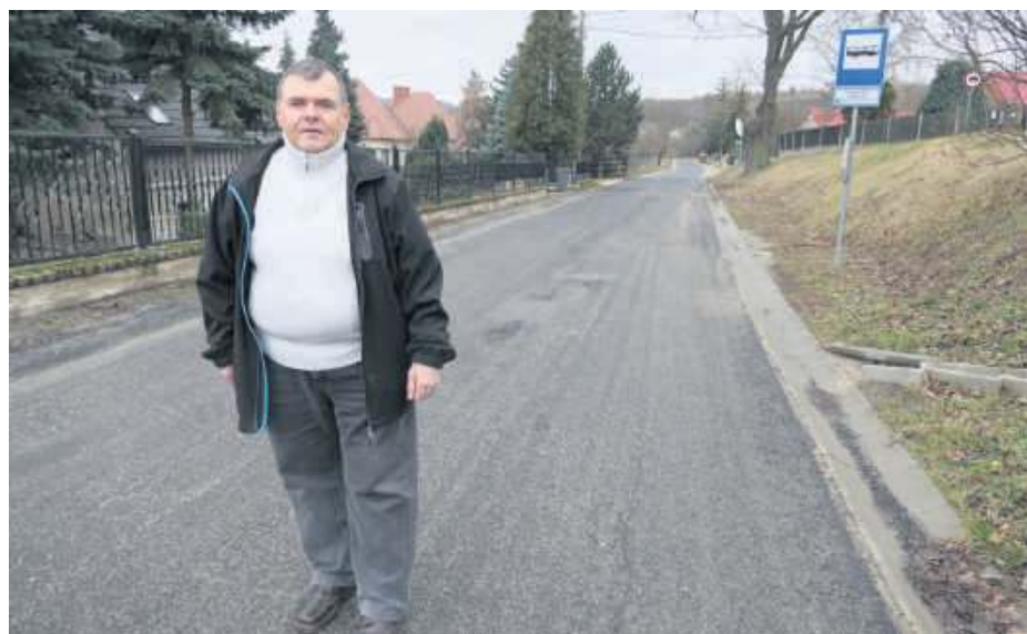
Sołtys Adam Daniluk opowiedział o planowanym remoncie drogi w Kuropatniku. Chodzi o odcinek od skrzyżowania ulicy Strzelińskiej z Widokową do widocznego na zdjęciu fragmentu ulicy Kaczerki
