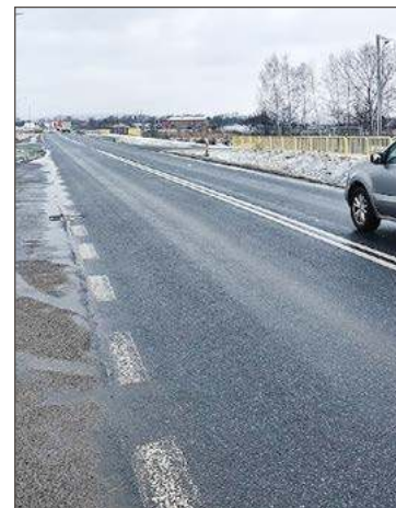
Na tym odcinku doszło do wypadku.
