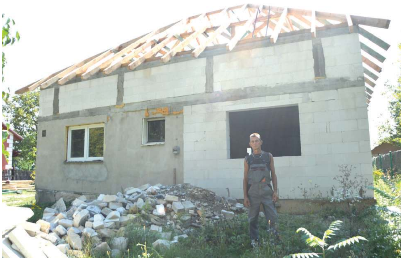
Pan Krzysztof większość prac przy odbudowie domu wykonuje sam. W ubiegłym tygodniu kryty był dach
