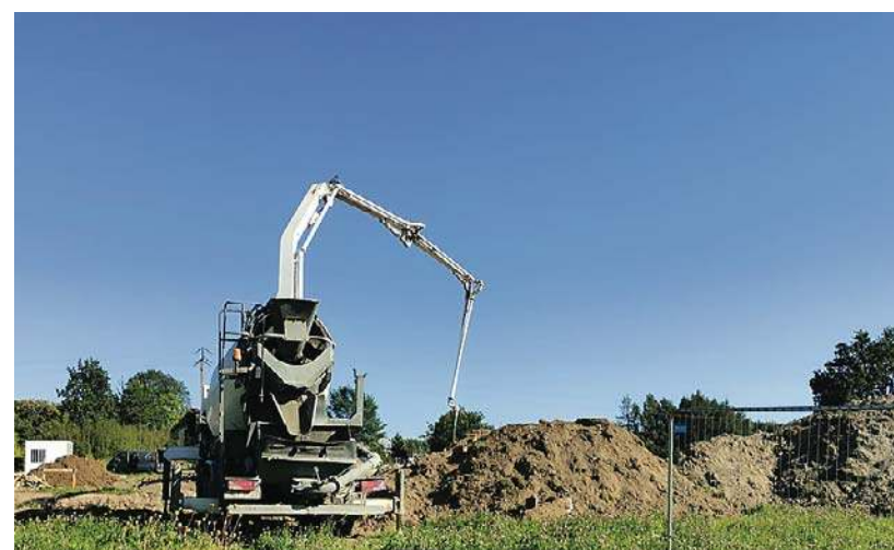
Pierwsze prace na placu budowy w Godkowie
