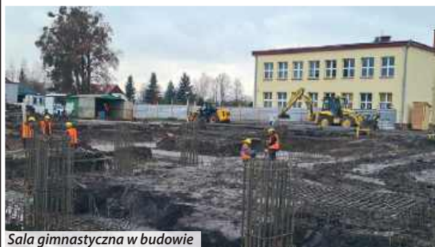
Sala gimnastyczna w budowie
