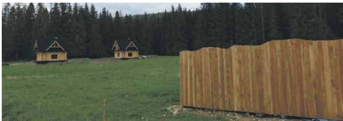
W Witowie na Polanie Baligówka przybywa nowych szalasów i domków rekreacyjnych, dziś to wielki plac budowy.
