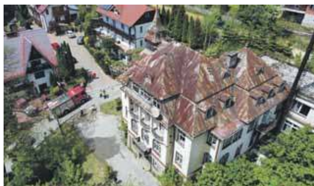
W ubiegłą środę w willi Renata w Szczawnicy wybuchł pożar.
