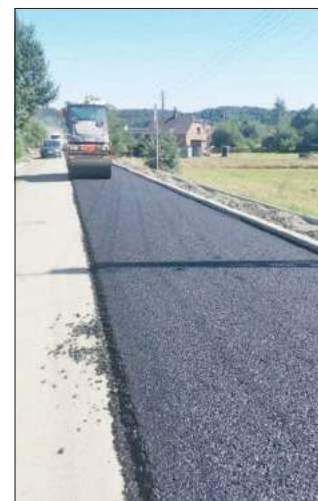
Według zapowiedzi Starostwa, prace remontowe potrwają do końca roku.
