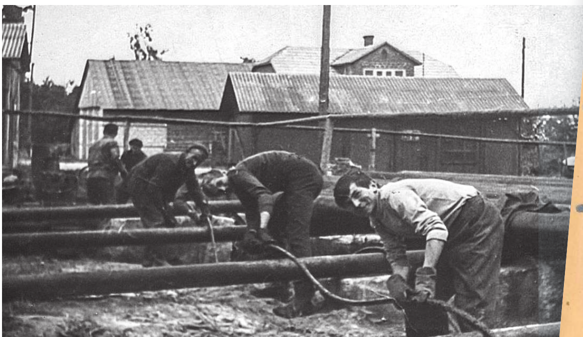
Budowa pierwszych gazociągów – Kopalnia Przemyśl-Zachód
