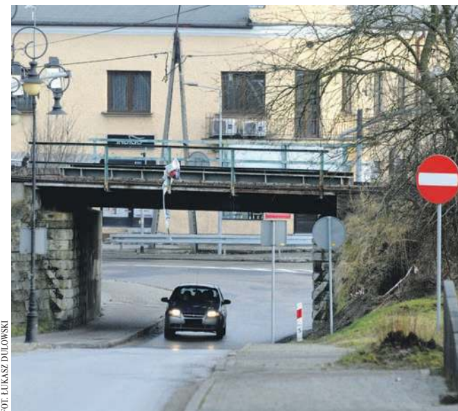
Wiadukt kolejowy nad ul. Krakowską w Chrzanowie
