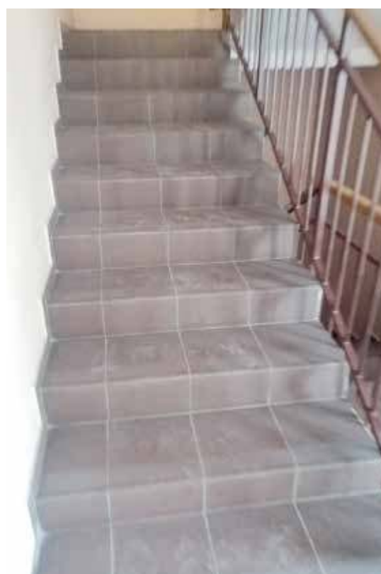
Ułożono już terakotę na schodach prowadzących na piętro UG
