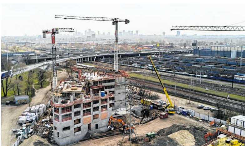
• Budowa osiedla przy estakadzie Trasy Toruńskiej
