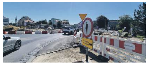
Trwają prace związane z przebudową strzelińskiego ronda
