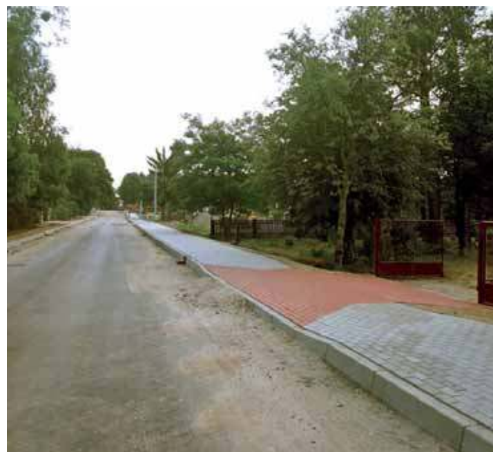
Droga w Mącicach będzie bezpieczniejsza
