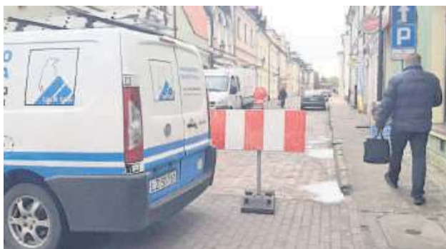
Ulica Staszica formalnie jest już placem budowy.
