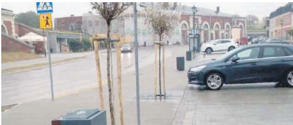
Na przebudowę ul. Łukasieńskiego i pl. Stefanidesa miasto otrzymało dofinansowanie z Funduszu Dróg Samorządowych.
