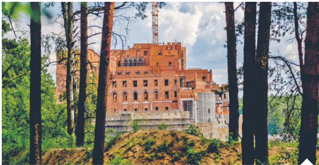
Trwa budowa w sercu Puszczy Noteckiej | fot. Robert Woźniak
