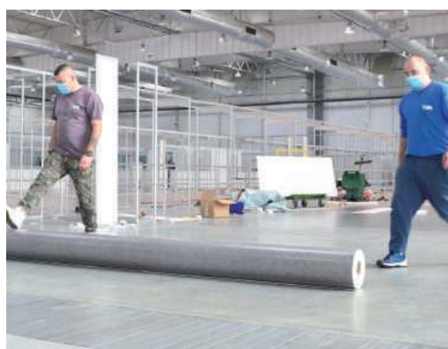
W budynku ustawiono kontenery sanitarne (przystosowane dla osób niepełnosprawnych), tworzona jest zabudowa: brudowniki magazyny, działy farmacji, pomieszczenia dla personelu
