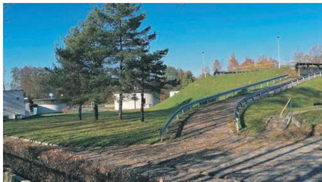
Oczyszczalnię ścieków przy ulicy Sanitarnej w Libiążu czeka modernizacja
