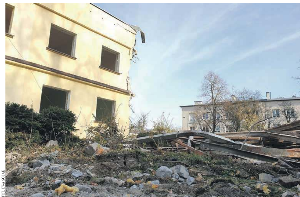
W ich miejscu powstanie nowy, kilkupiętrowy budynek
