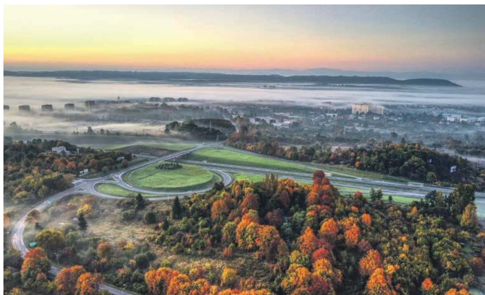
Węzeł baliński na autostradzie A4 w Chrzanowie
