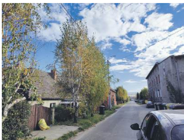
Brzozy swoimi koronami oplatają biegnącą nad nimi linię energetyczną
