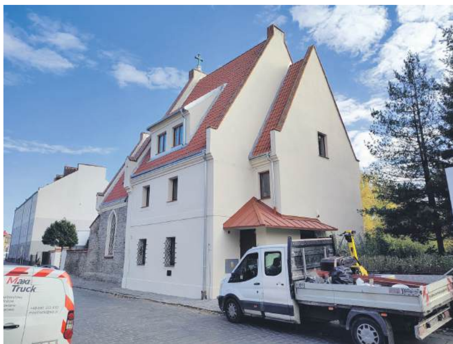
W Galerii Skalnej przy ul. Brzegowej trwają ostatnie prace wykończeniowe
