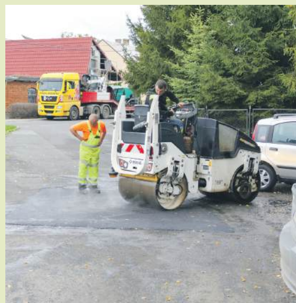
Remonty częściowe dróg powiatowych prowadzone były także w Przewornie na ul. Strzeleńskiej
