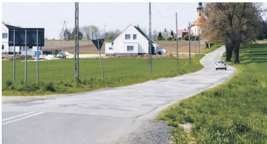
W ramach Programu Rozwoju Obszarów Wiejskich na lata 2014-2020 zaplanowano przebudowę drogi w Przewornie na ul. Siemysławickiej
