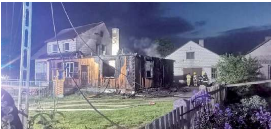
Drewniany dom gasiło sześć zastępów straży. Niestety budynek uległ całkowitemu spaleni (fot. OSP KSRG Okrzeja)
