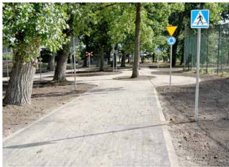
W miasteczku rowerowym nie zapomniano też o budowie ronda
