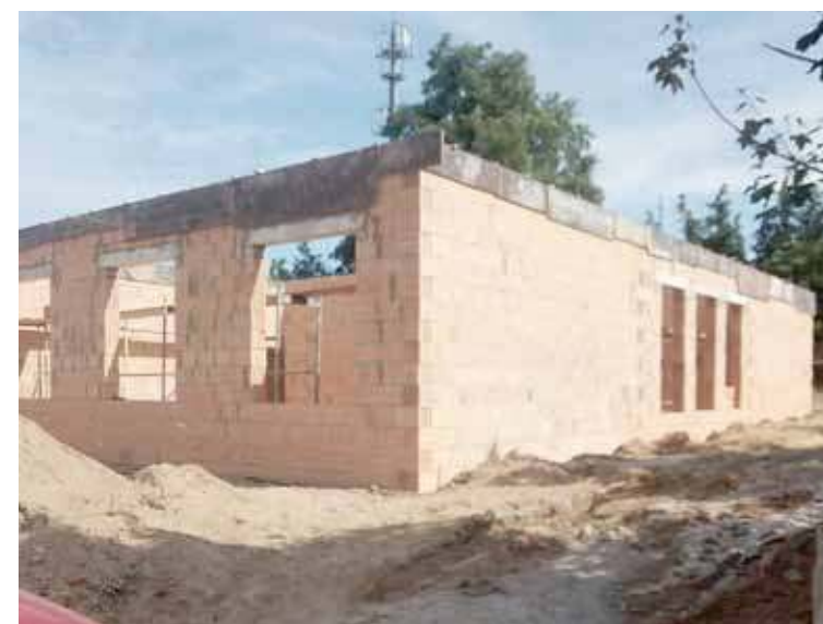
Nowe, parterowe skrzydło szkoły powstaje w mgnieniu oka. Wszystko ma być gotowe w grudniu
