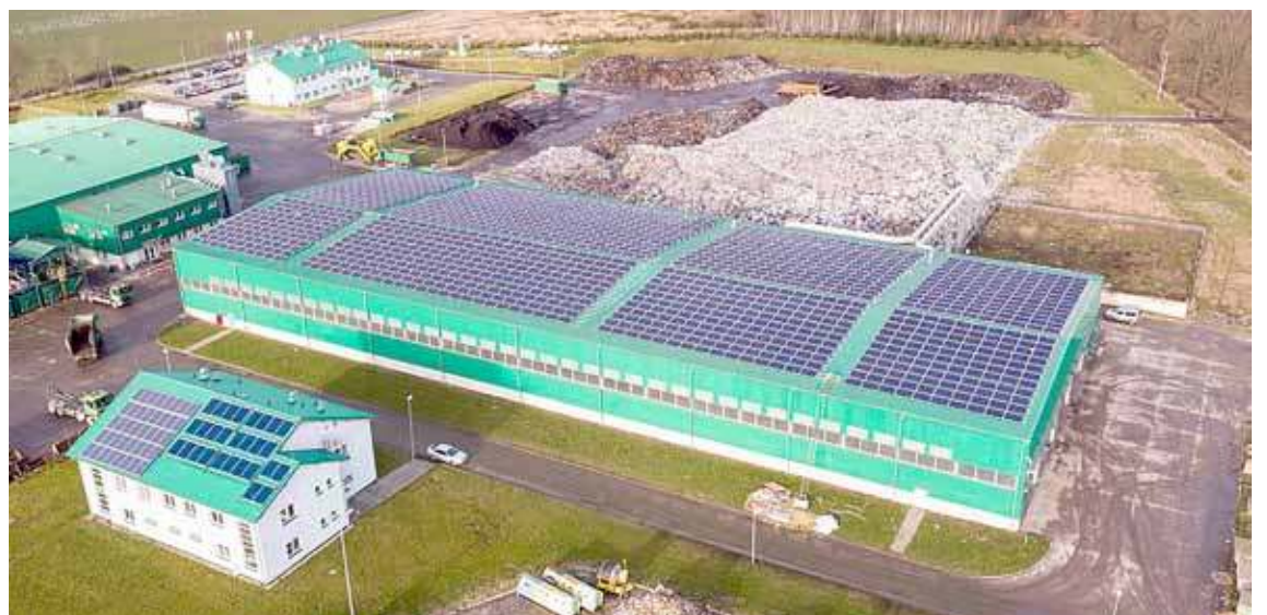
Zakład w Słajsinie- niedawno doposażony w fotowoltaiczne panele na dachu, w celu zmniejszenia kosztów energii elektrycznej
