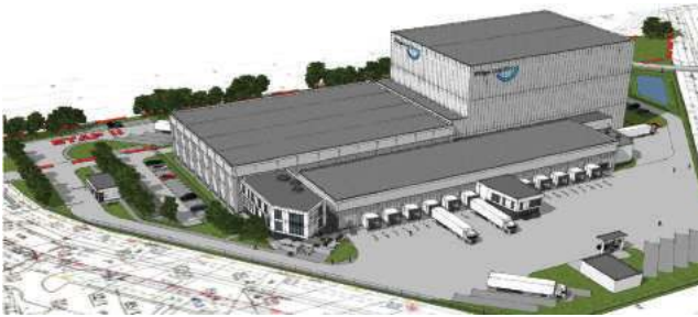
Zakończenie budowy przewidziane jest na koniec przyszłego roku
