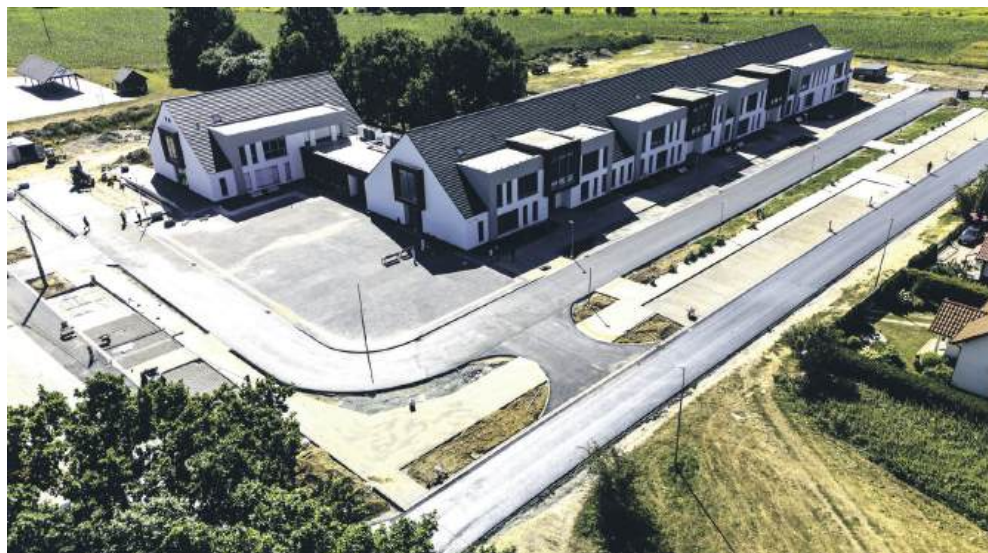
Prace przy zagospodarowaniu przy szkole dobiegły końca
