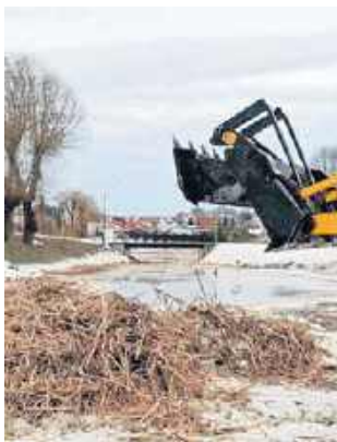
Zbiornik i jego brzegi oczyszczono z roślinności
