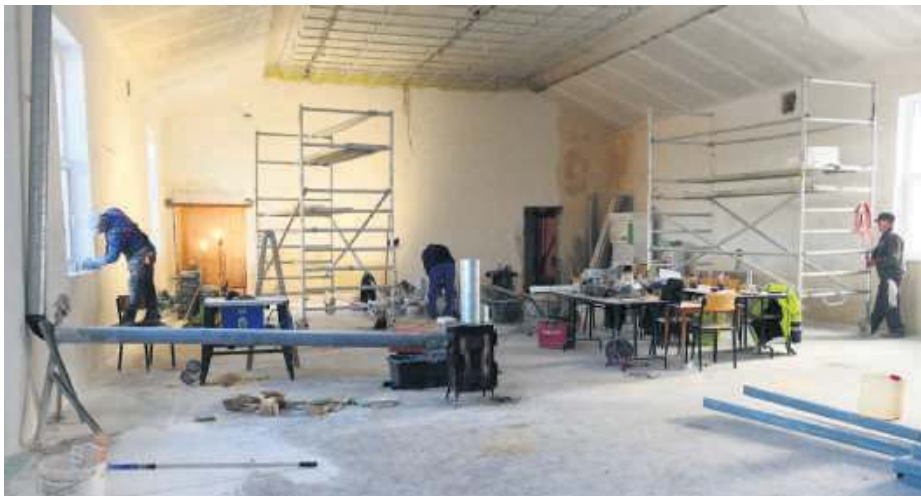
Obecnie w świetlicy wiejskiej w Wyszonowicach trwają zaawansowane prace remontowe
