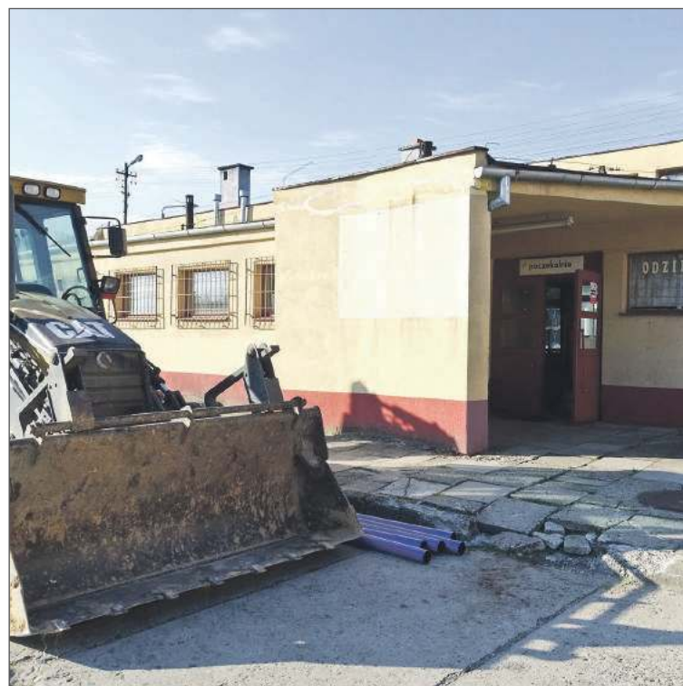
To już ostatnie dni dworca kolejowego w Czarnej.
