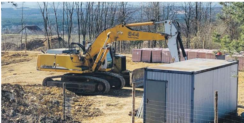
(AF) Plac budowy nowego osiedla w Trzebini
