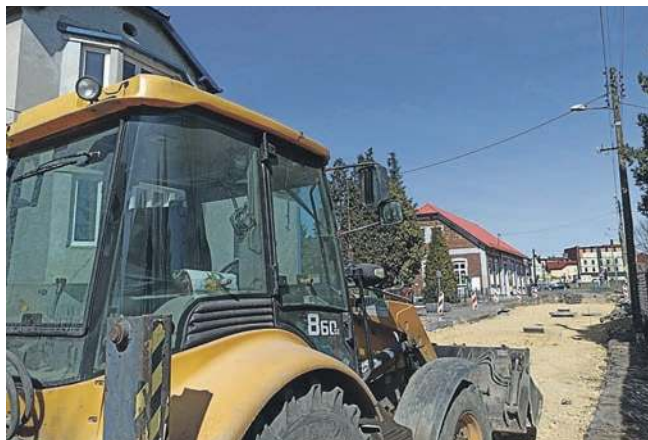
Ulica Ochronkowa rozkopana - trwają roboty drogowe
